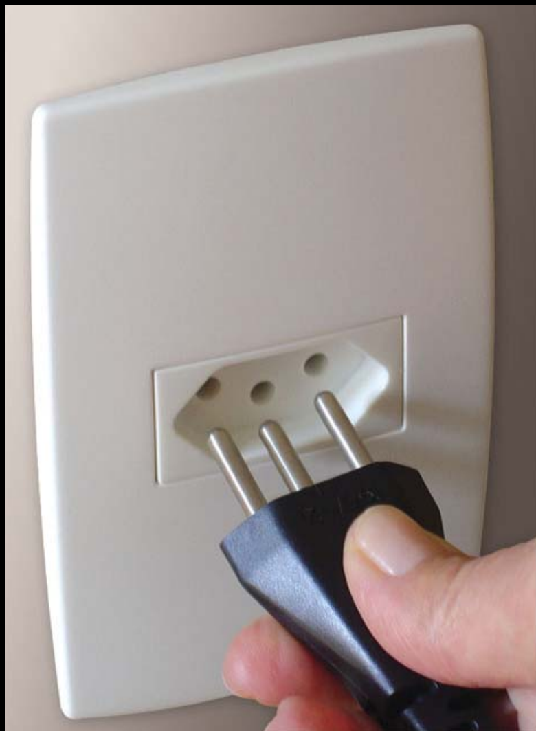
Plugue de equipamentos classe I (plugue 2P+T)
